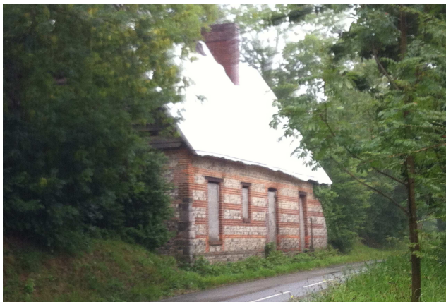
La grange que la mairie va restaurer
